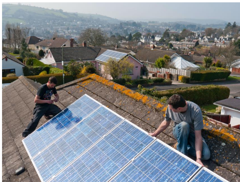
Figura 10: Partecipanti al movimento delle Transition Towns che installano pannelli solari su un tetto 6
